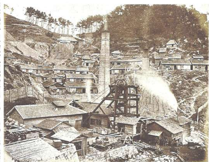
③稼働中の南洋井坑
